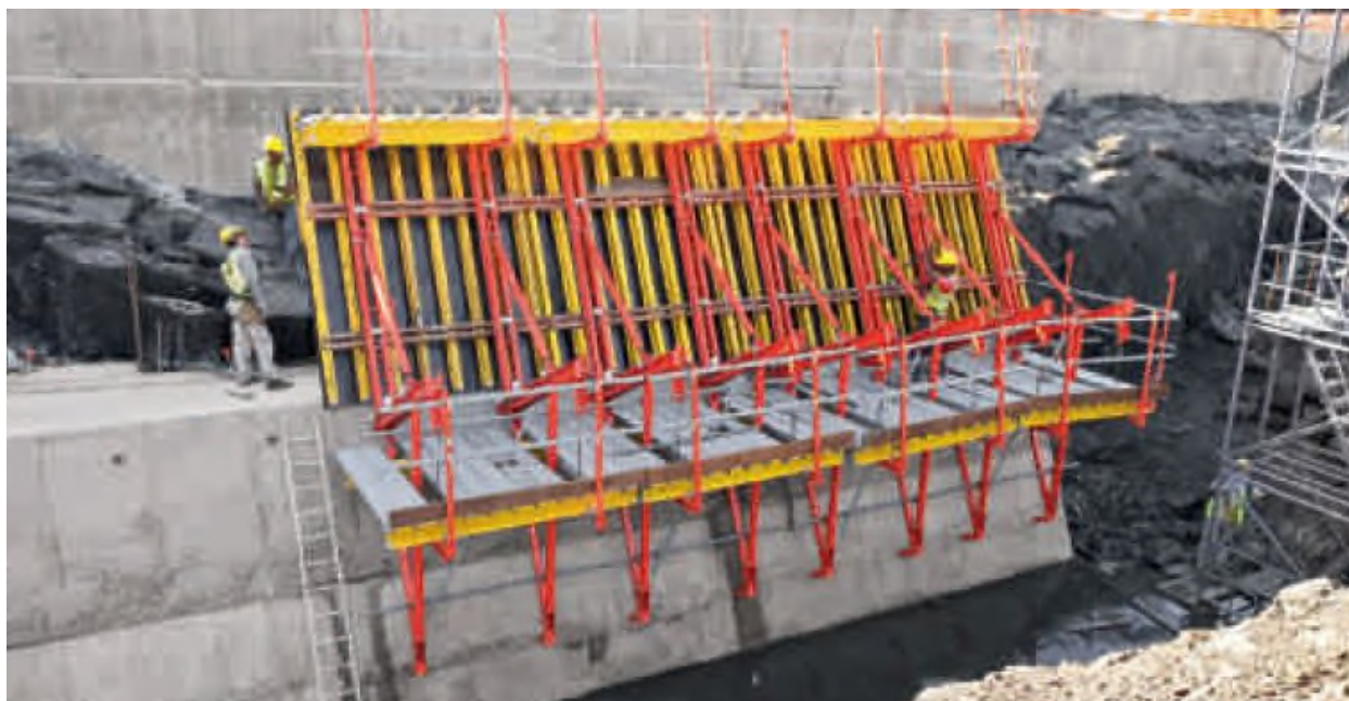
Figura 8 – Esempio di ponti di lavoro costituiti da mensole speciali da fissarsi alla struttura di sostegno dei casseri rampanti
