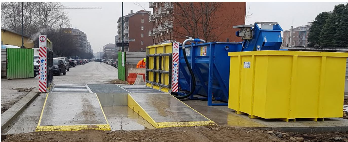
Figura 5 – Esempio di impianto lavar ruote da posizionare in corrispondenza degli ingressi alle piste di cantiere
